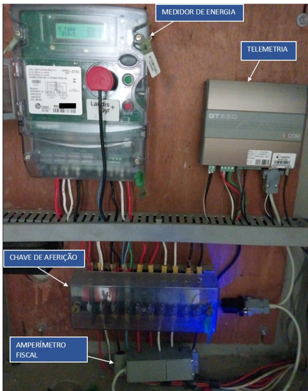
Figura 4: Amperímetro fiscal instalado
